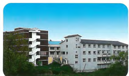
기숙사 2동(1동 추가 건축 중)
