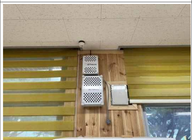
연동형 라돈측정기, 라돈관제시스템 설치(행정실)
