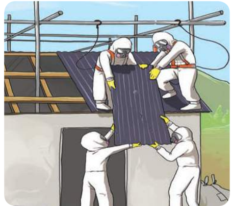
비계·안전고리 설치 및 페슬레이트 안전제거
