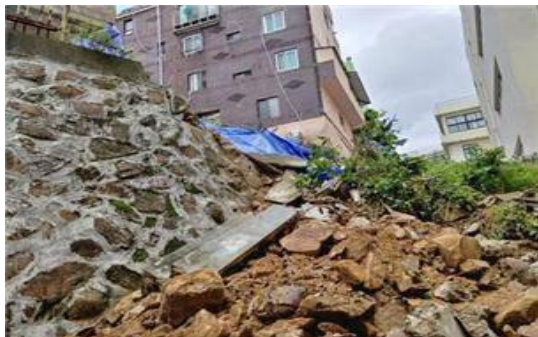
부산 OO고등학교 석축붕괴로 인한 건물 피해 사진 (2020.7)
