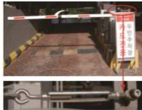
<그림 III-61> 락너트의 사용 예
