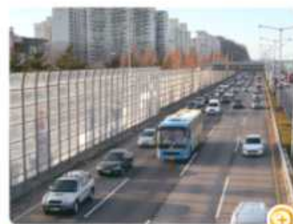
▲ 소리가 반사되는 성질을 이용한 도로 방음벽
